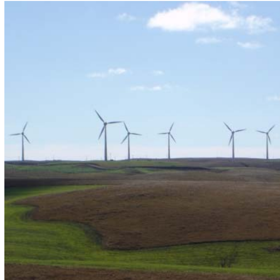
Horizonte Windpark, Bundestaat Santa Catarina 8 x E-40/600 kW = 4.8 MW Betreiber: CENAEEL Stromabnehmer: CELESC (Energieversorger)
