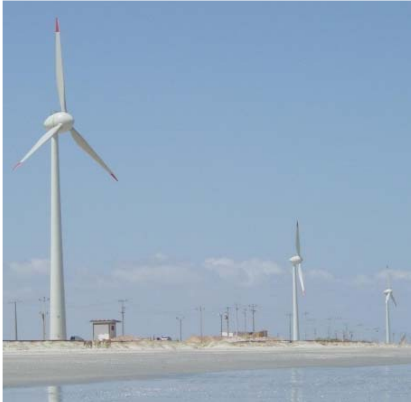
Macau Windpark, Bundesstaat Rio Grande do Norte 3 x E-40/600 kW = 1.8 MW Betreiber: PETROBRAS Stromabnehmer: Eigenbedarf
