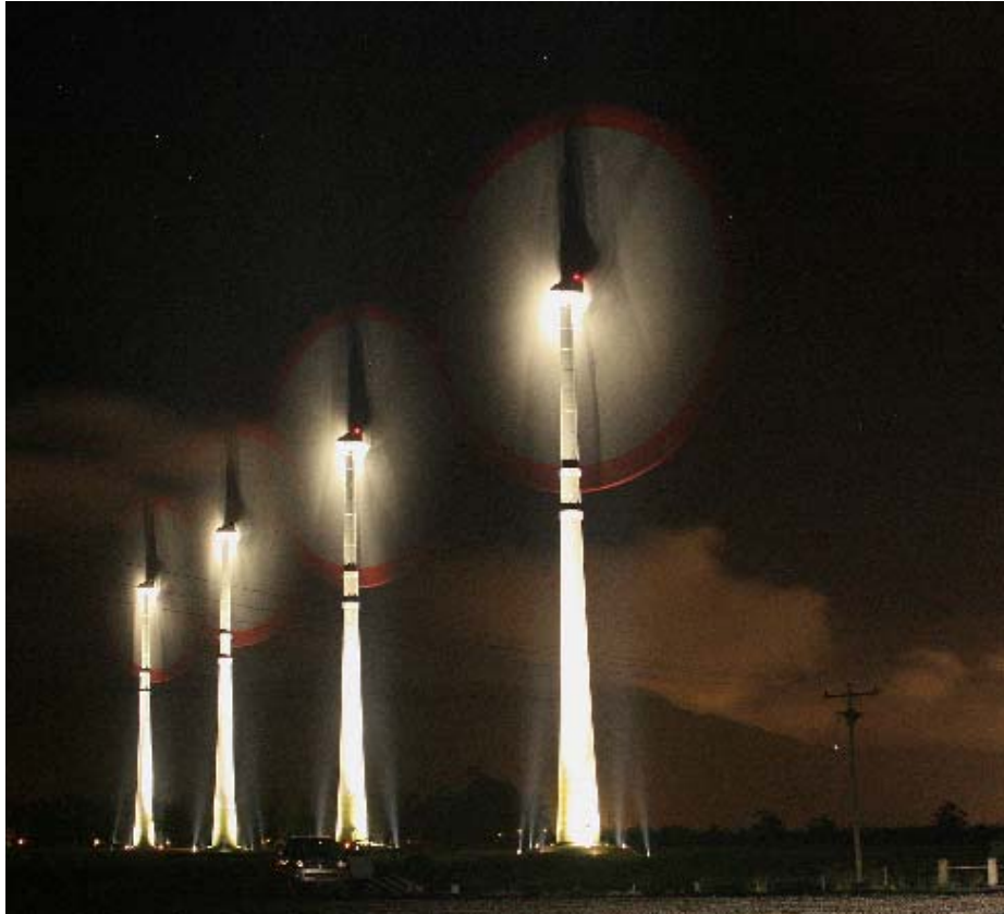
Osório Windpark, Bundesstaat Rio Grande do Sul 75 x E-70/2000 kW = 150 MW, 98 m Betontürme Betreiber: Ventos do Sul/Enerfin/Elecnor Stromabnehmer: CEEE (Energieversorger)
