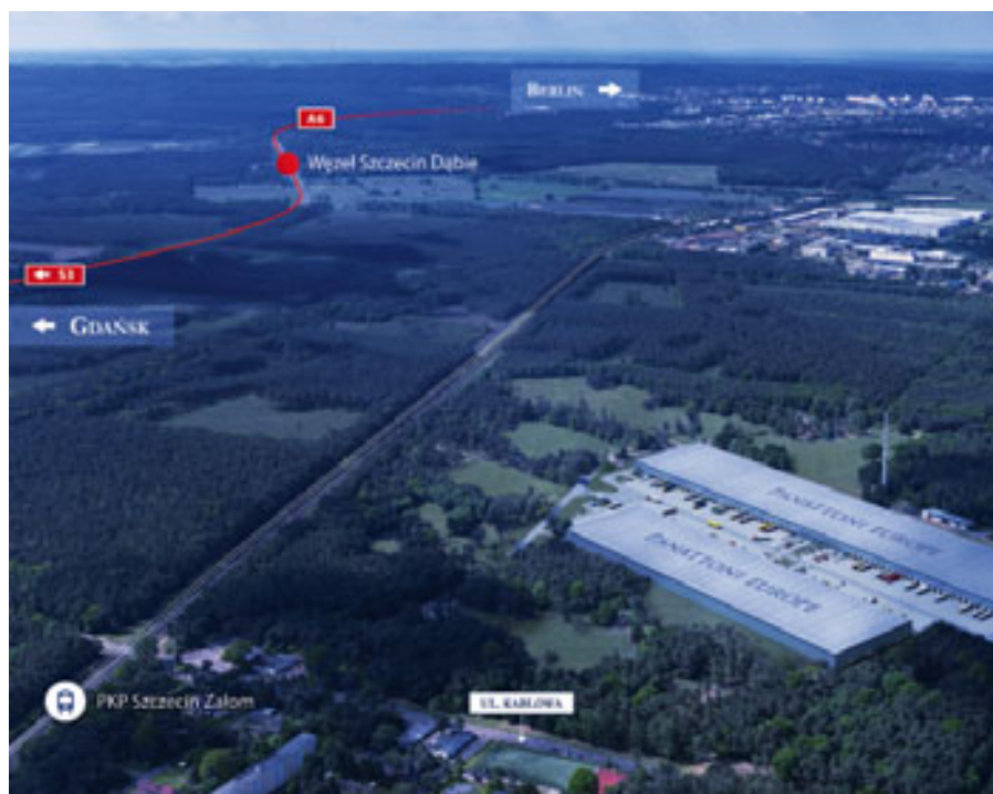
Der Panattoni-Park bei Szczecin ist einer von vielen Logistikparks, der sich im Bau befindet.
